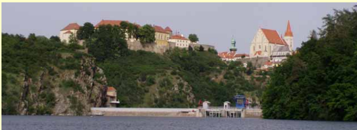
Vodní nádrž Znojmo- hráz
